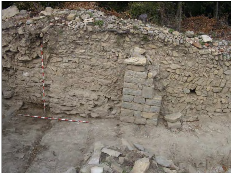
FIGURA 5. Mur nord construït amb opus spicatum. Pilar i restes d'una estructura anterior
