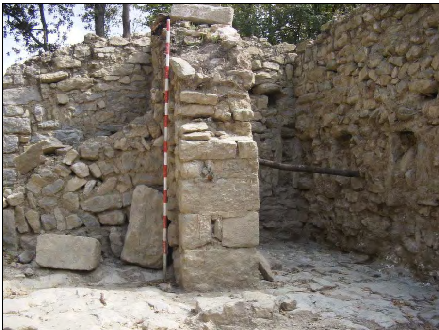
FIGURA 4. Detall de l'escala ja excavada amb el mur de suport i espitlleres al fons, sota l'escala
