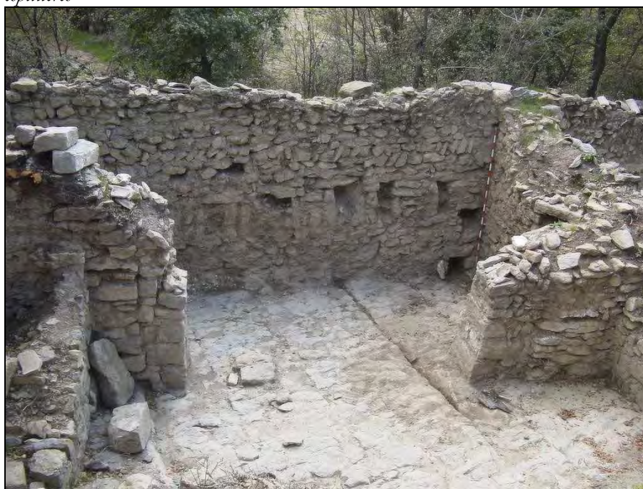
FIGURA 9. Les dues parts del gran arc que aguantava el pis superior. Al fons espitlleres
