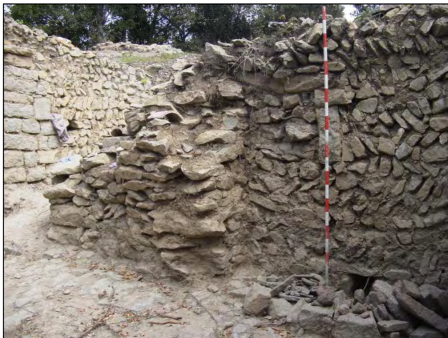
FIGURA 6. Mur transversal detall d'opus spicatum. Pilar segurament amb base d'estructures anteriors
